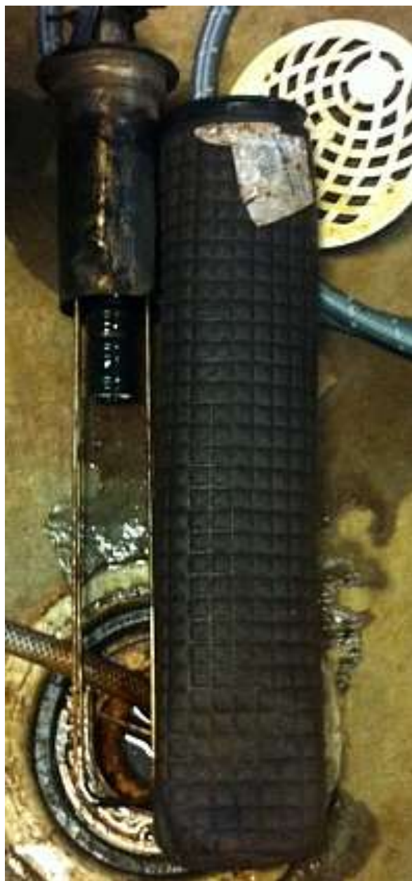
Filterinsats och magnetfälla efter en vecka
